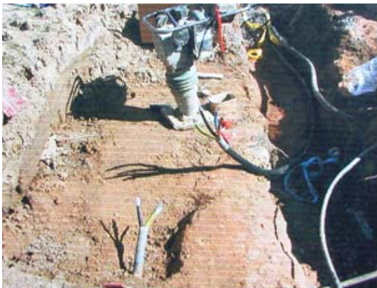
Bild: gespreizte Kabelenden der zu schließenden Ringleitung
